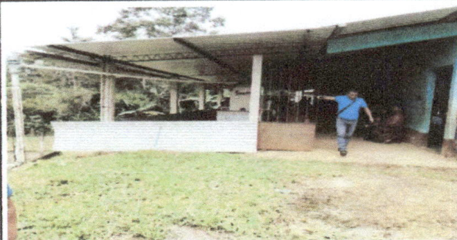
Foto 10: Reparación de puerta del corredor del módulo No. 01.
