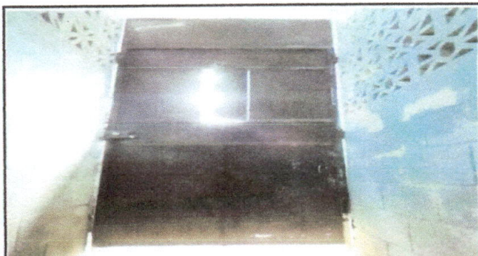
Foto 3: Cambio de puerta principal del módulo No. 02.
