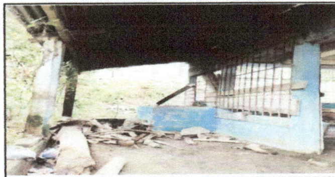
Foto 6: Reparación de piso al fondo del módulo No. 02.
