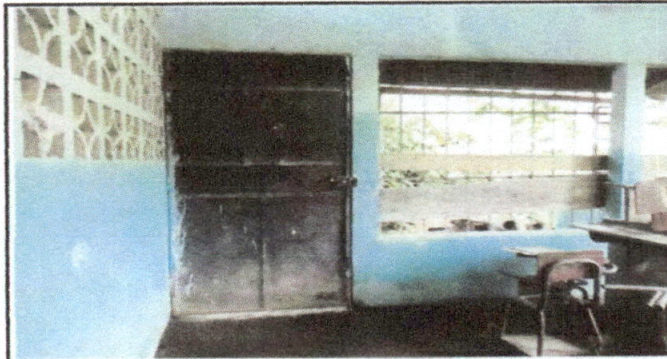
Foto 4: Cambio de chapa de puerta al fondo del módulo No. 02.
