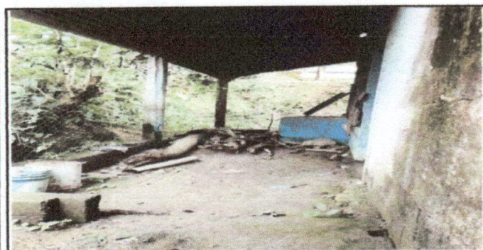
Foto 5: Reparación de pared al fondo del módulo No. 02.
