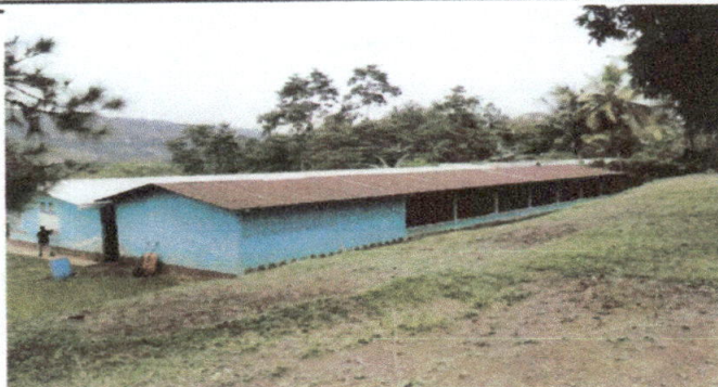
Foto1: Sustitución de láminas a troqueladas de 36 X 6.92 mts. del módulo No. 02 e instalación de canales de agua pluvial.
